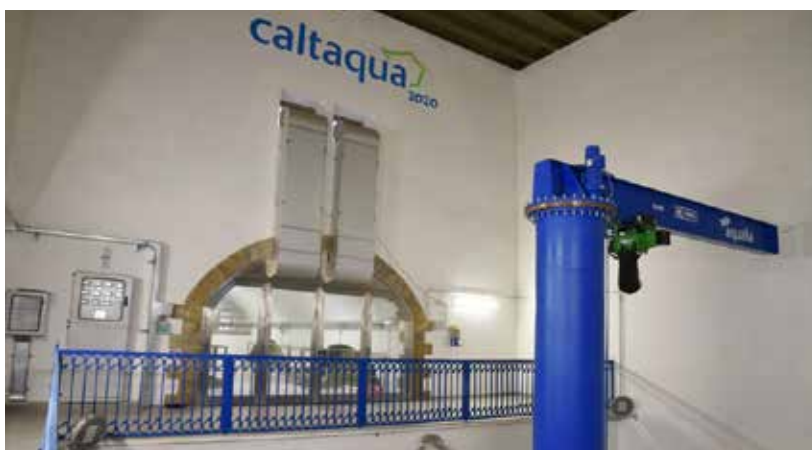
Interno serbatoio San Giuliano – Caltanissetta
